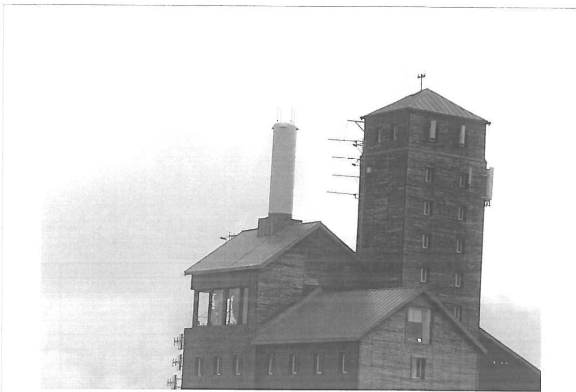
Fot. 1. RTON Jelenie Góra / Śnieżne Kotły – widok obiektu
